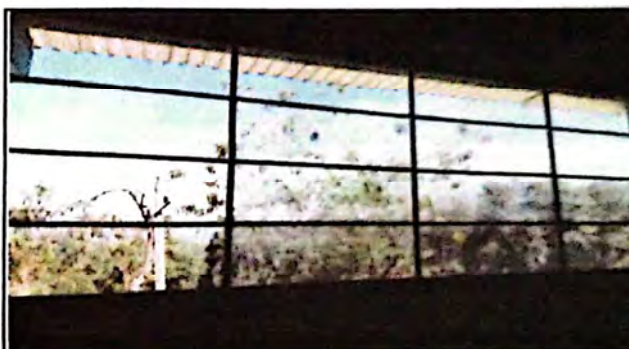
Foto 4: Sustitución de ventana
