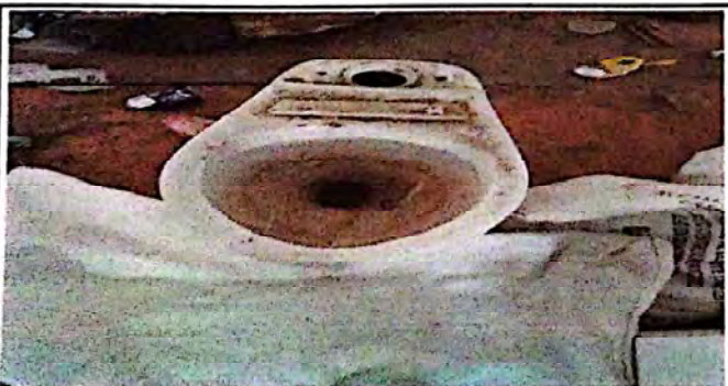
FOTO 5: Instalación de sanitarios.
