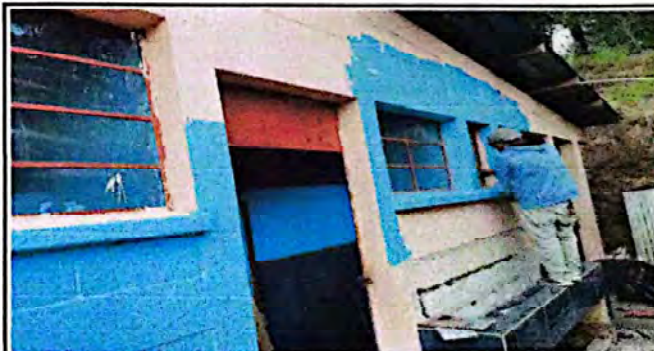
FOTO 6: Reparación de lava manos.
