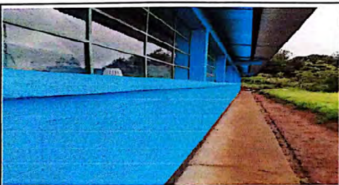
FOTO 3: Sustitución de vidrios.
