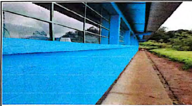
FOTO 4: Sustitución de vidrios.
