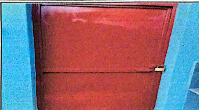
FOTO 2: Instalación de puerta
