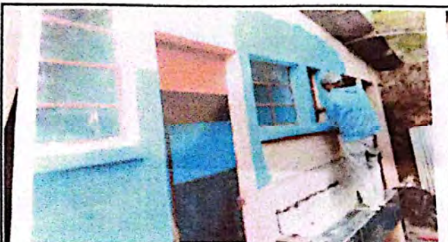
Foto 3: Sustitución de vidrios
